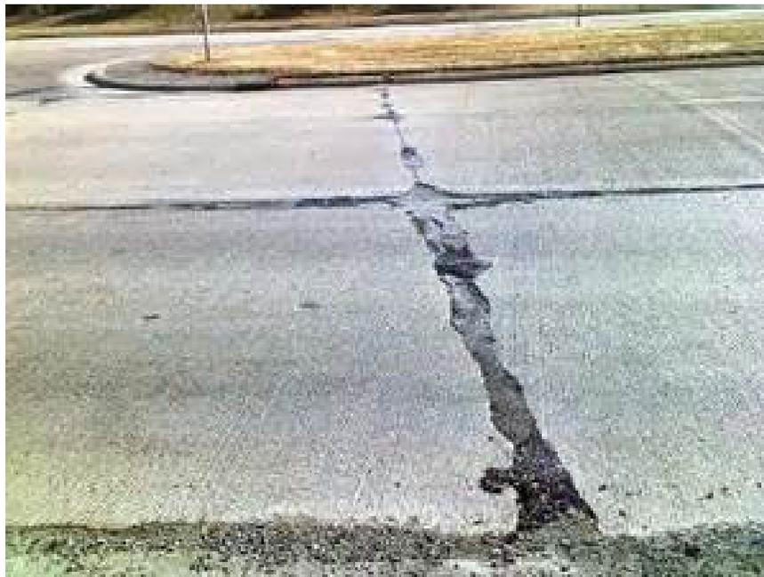
FIGURE 6.7. SPALLING ALONG A LONGITUDINAL JOINT (PHOTO FROM [93])
